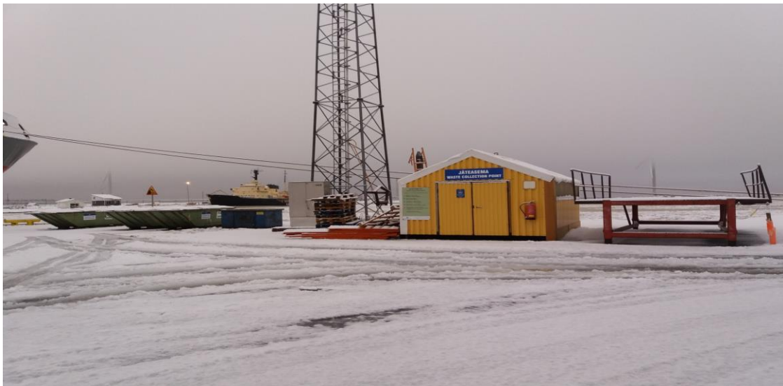
Laituri 1:n jäteasema
